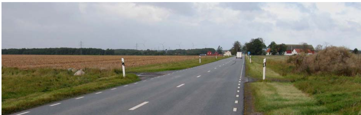
Väg 1648 från öster. Infarten mot damm 90-17 skymtar på vägens vänstra (södra) sida. Dammen ligger ca 300 m från vägen.
