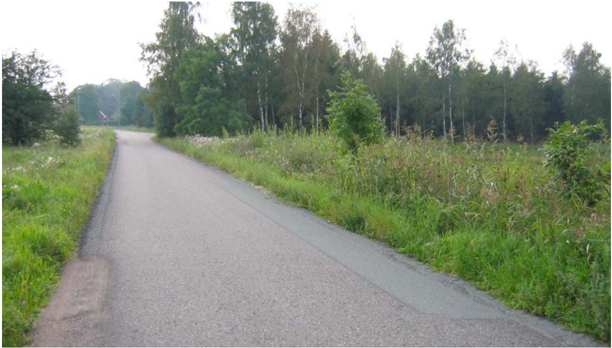
Damm 65-13 (Klockaregården). Dammen ligger just till höger om vägen, bakom buskage och vass. Bilden tagen mot söder.
