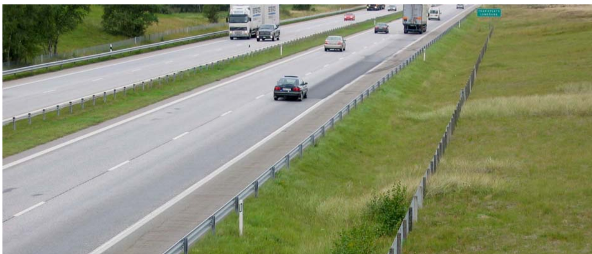
Väg E6 som löper genom friluftsområdet Järavallen. Bilden tagen mot norr, från en gångbro. Observera ”vajerräcke” i mittrenen, sidostaket och stängsel, typ ”Gunneshöj”.
