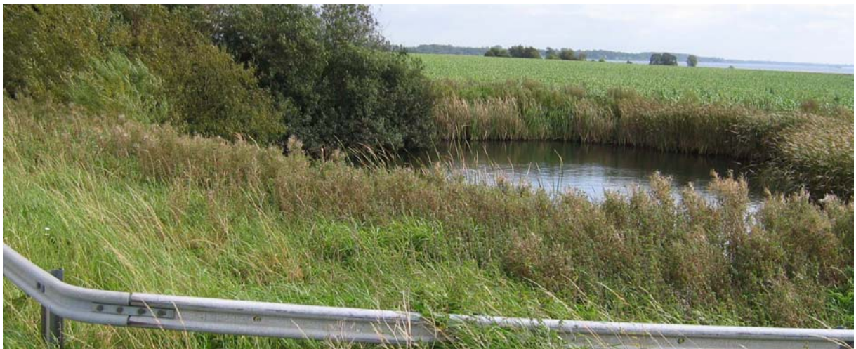
Damm 61-11 (Vikhög). Staketet i förgrunden gränsar till väg 1135.
