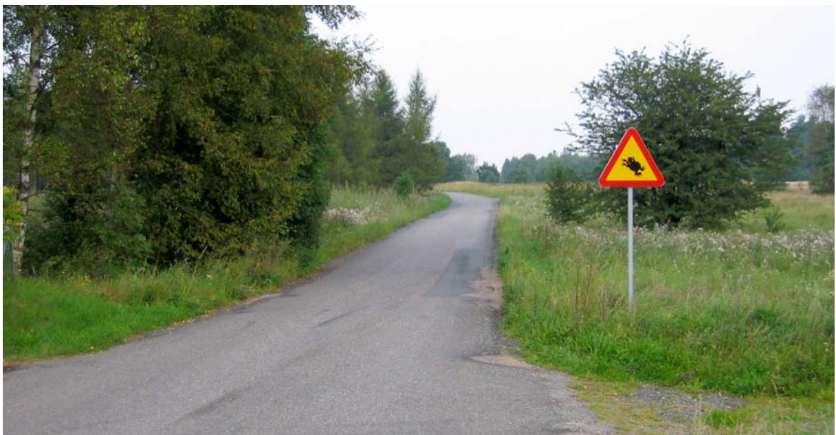
Enskild väg just öster om damm 65-13 (bakom stora mörkgröna buskaget till vänster). Observera varningsskylt för grodor. Bilden tagen mot norr.
