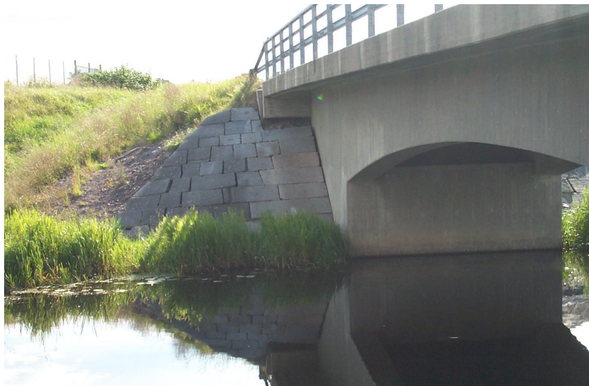
Foto 6: Ulva – Hög bro med överhäng utan strand. En betongbro där väg C 631 korsar Fyrisån. Detta är ett exempel på en bro med fälla. Vägbanan sticker ut utanför fundamentet och bildar ett tak ovanför sluttningen som består av större stenar. Uttern klättrar upp för stenbranten och använder glipan som finns mellan stenarna och betongfundamentet som markeringsställe eller boplats. Det är vidare mycket troligt att uttern när den väl är uppe vid kanten även blir intresserad av att ge sig upp och över vägen. Om en landpassage byggs under bron bryr sig uttern förhoppningsvis inte om överhänget längre.
