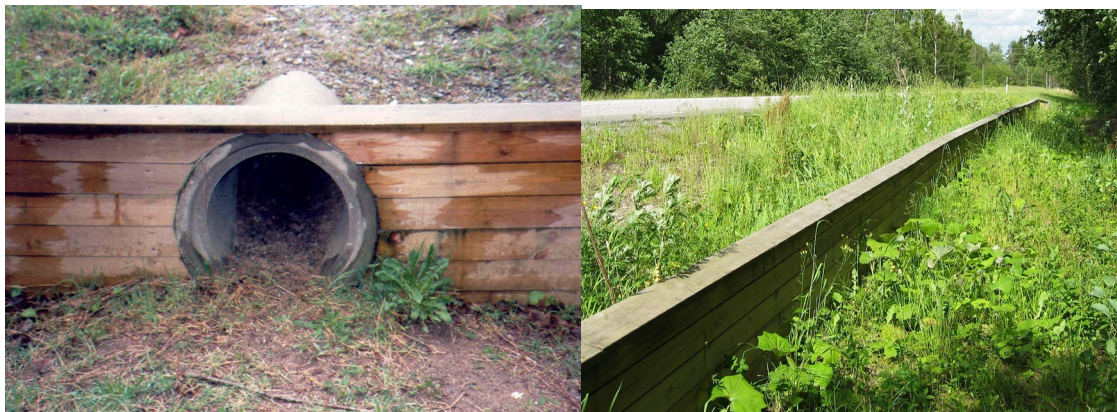
Foto 1: Grodtunnel i Fjugesta, tunnel.
