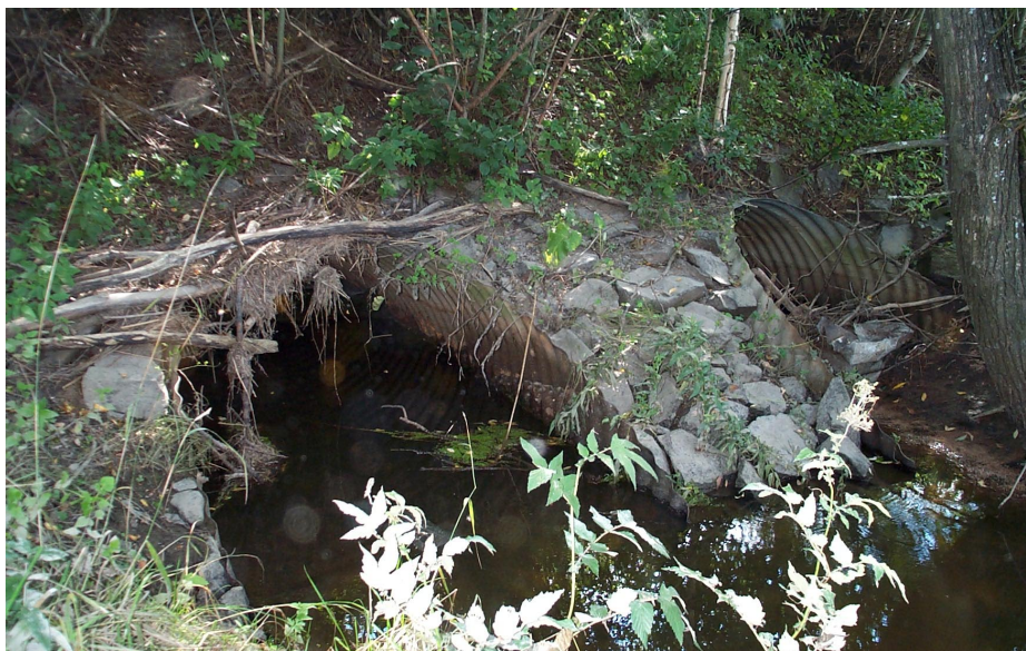
Foto 3: Gunsta - Igenrasad trumma. Särskilt vid högvatten eller starkt strömmande vatten väljer uttern att gå över vägen. För mer information om denna lokal, se avsnitt 6.2.2 .
