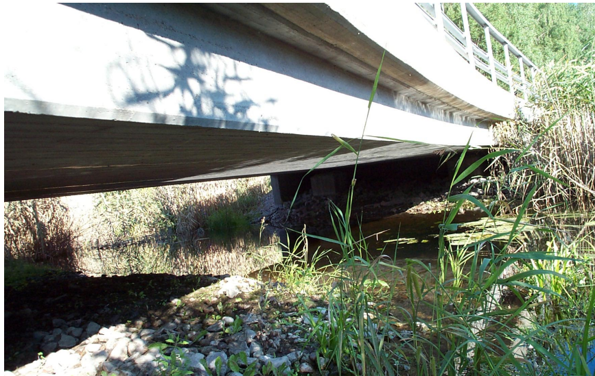
Foto 5: Sätuna - Bra låg bro. Ett exempel på en bra och låg bro ligger vid Sätuna. Det är en betongbro där grusväg C766 korsar Sävastabäcken. Under bron finns hel landbrygga på båda sidor, även vid högvatten.
