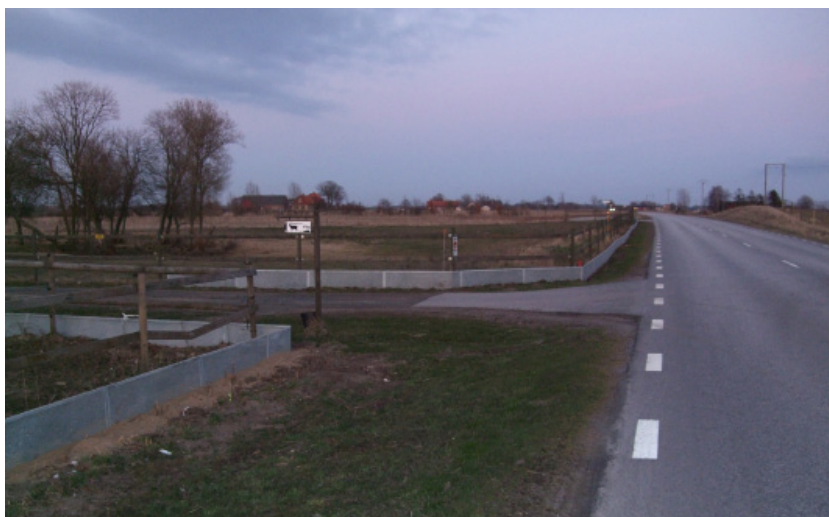
Figur 10. Grodstaket uppsatt i Häljarp.
