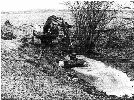
Ugrävning av vattnet börjar.
